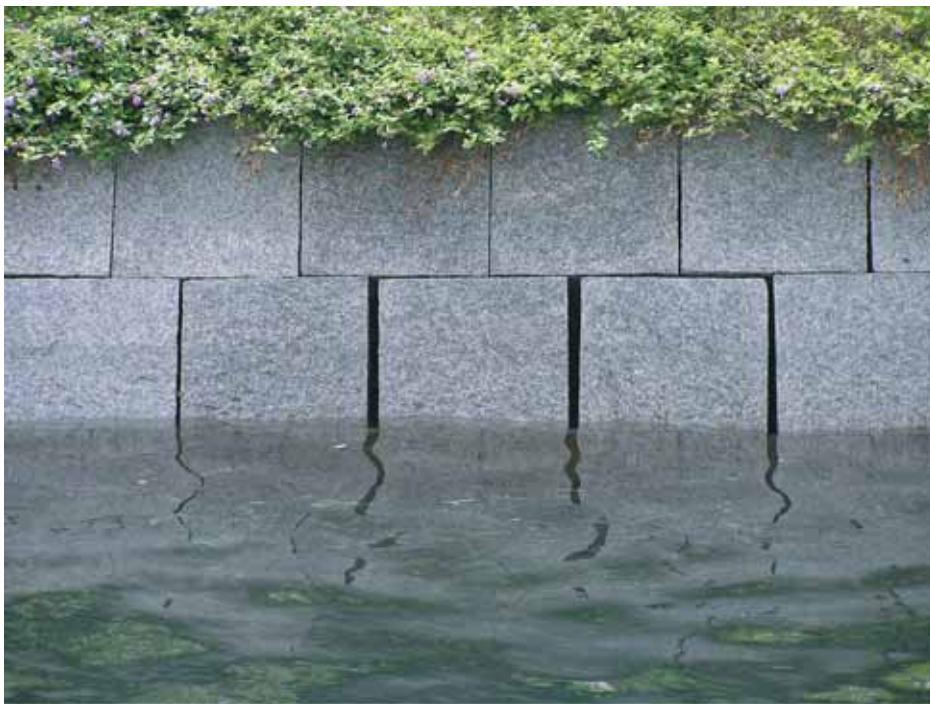
「空石積」の水路護岸
