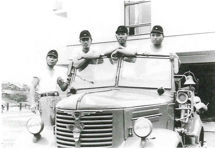
昔懐かしいボンネット型ポンプ車
