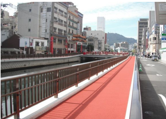
写真 30 <県営駐車場撤去後の歩道等整備>
