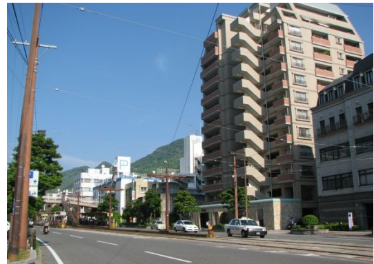
写真 6 <国道 34 号沿いのマンション>
