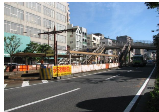
写真 8 <新大工町電停>
