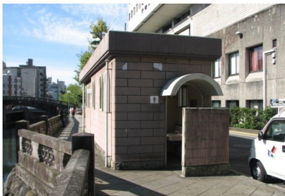
写真 - 15 < 公衆トイレ (市民会館前) >
