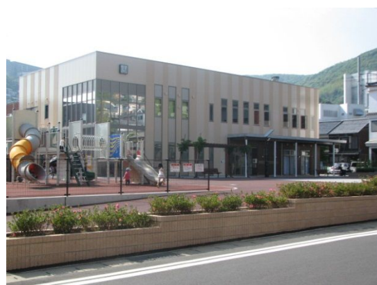
写真 - 4 <上長崎地区ふれあいセンター>
