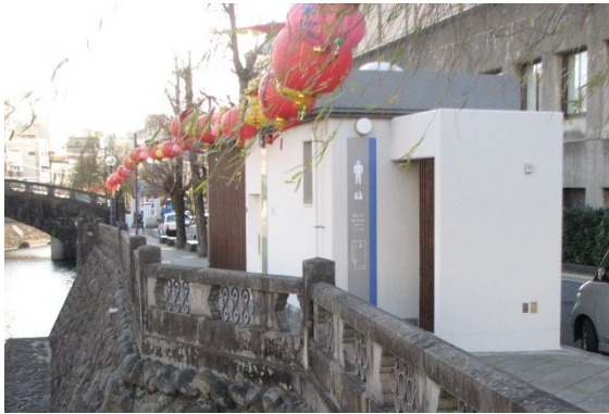
写真 - 15 < 公衆トイレ (市民会館前) >
