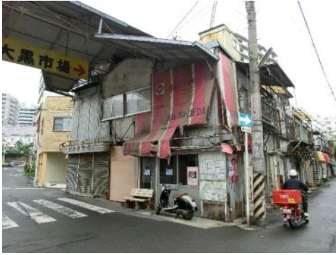
写真 - 24 < 解体前の大黒市場 >
