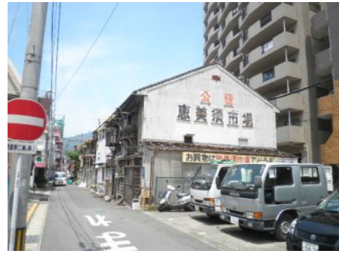
写真 - 25 < 解体前の恵美須市場 >
