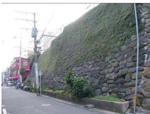
写真 - 29 <大音寺坂の石垣>
