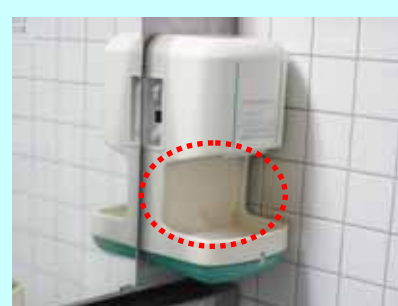
温風乾燥機を使用する場合は毎日清掃を行うこと
