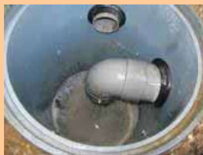
排水マスの清掃
