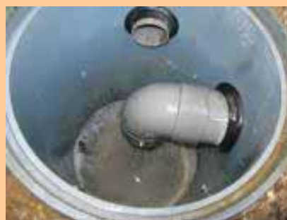
排水マスの清掃
