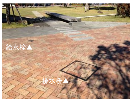
▲イベント用排水設備の例(宮崎・日向市) イベントに使いやすいように給排水設備を広場や街路内に設置しています。
