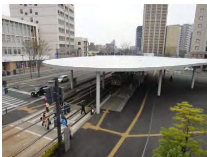
▲電停のシェルターの例(熊本駅市電)
