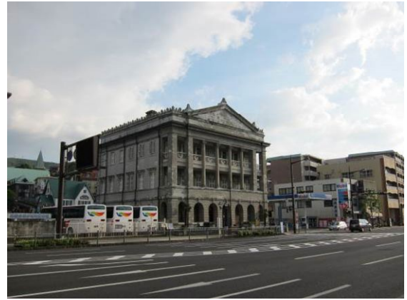
写真 - 4 旧香港上海銀行長崎支店記念館前 歩道橋の撤去後
