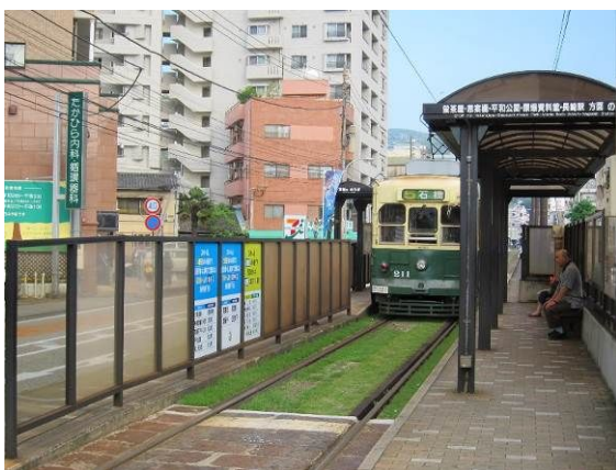
写真 - 16 路面電車の軌道敷の緑化 大浦天主堂下電停
