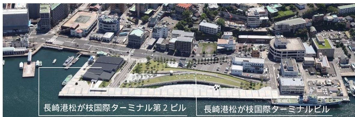
写真-2 長崎港松が枝国際ターミナル
