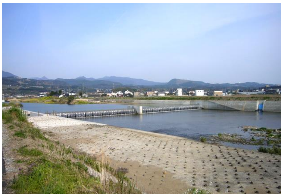
郡川・平四郎堰（H23完成）
