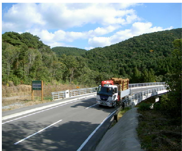
森林基幹道西彼杵半島線での間伐材運送状況
