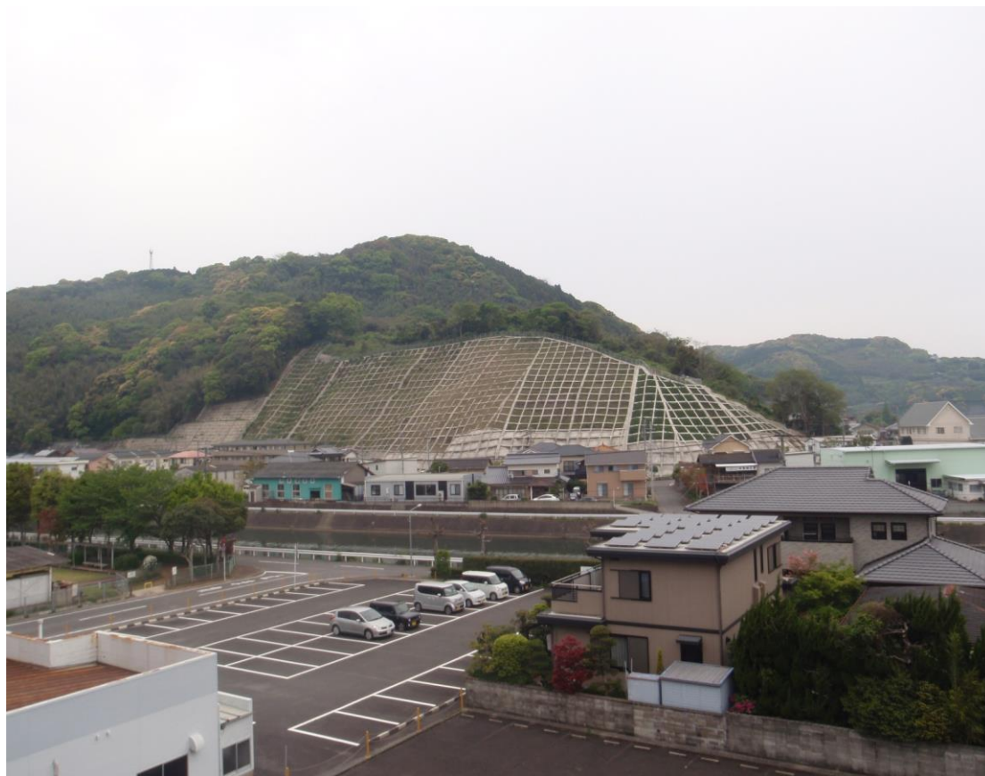
畠地区急傾斜地崩壊対策事業
