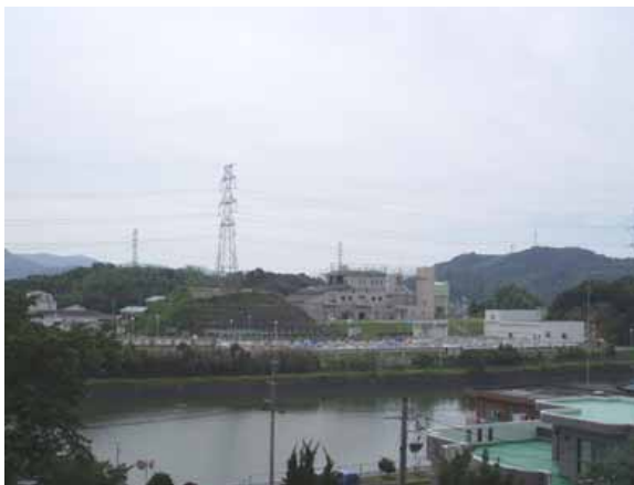
大村湾南部浄化センター
