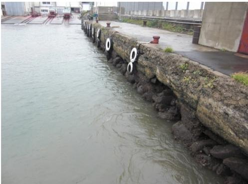
既設が古い石積構造であるため波浪等により倒壊の恐れがあった。(芦辺漁港)
