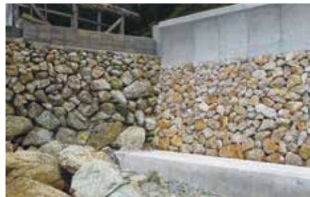
周辺景観に馴染む工法を採用した護岸
