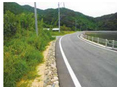
砕石敷きの側溝
