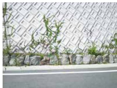
現場発生材を活用した植栽ポケット
