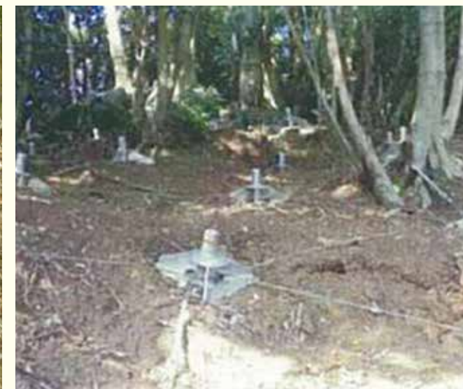
地山補強土工（ノンフレーム工）
