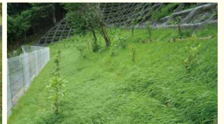
木柵工の下段は人家に配慮して、中低木(ツバキ、トバラ、マサキ等)を植栽した。
