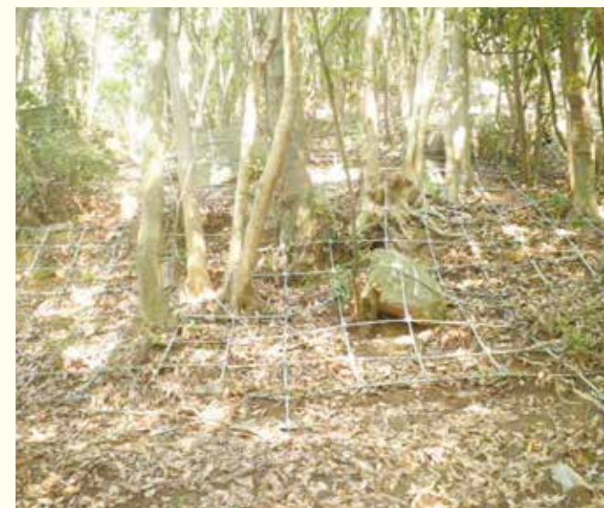
固定工（ロープネット工）
