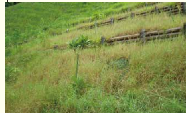
木柵工の上段は法枠を隠すために、高木(マテバシイ、スダジイ等の在来種)を植栽した。
