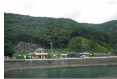
国道から見た斜面对策工
