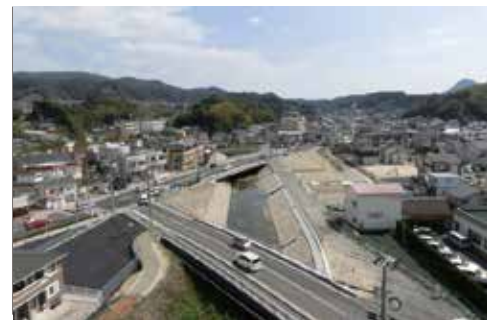
橋梁3橋の整備状況
