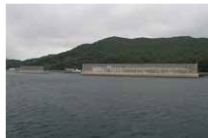
航路上から見た防風フェンス
