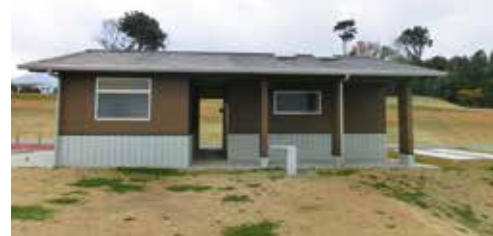
広場側から見たトイレ
