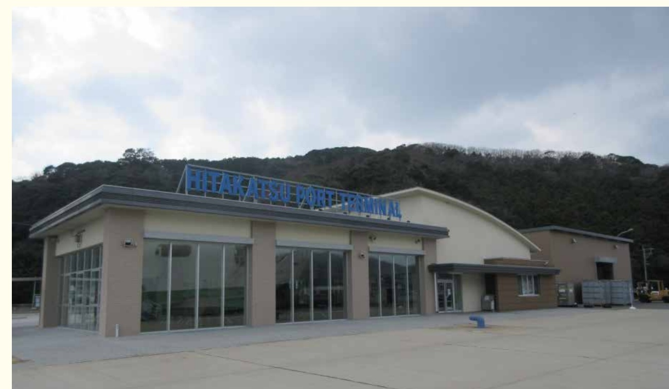
ターミナルの一部と倉庫の屋根の形状をフラットにし、景観性の統一を図った。（意見①②）
