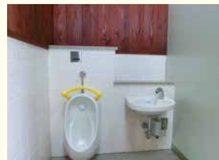
母親が男の子を連れて入れるよう、女性トイレにも子供用小便器を設置した。（意見③）
