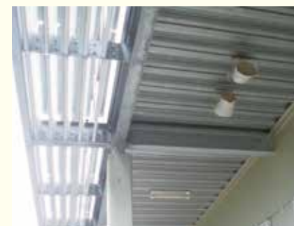
庇ルーバーに傾斜を付けることで開放渡り廊下への日光が遮断され、かつ通風が確保された。（意見④）
