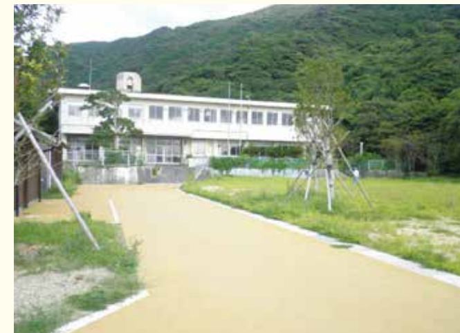
舗装（市事業）：トイレ整備と併せて施工した。
