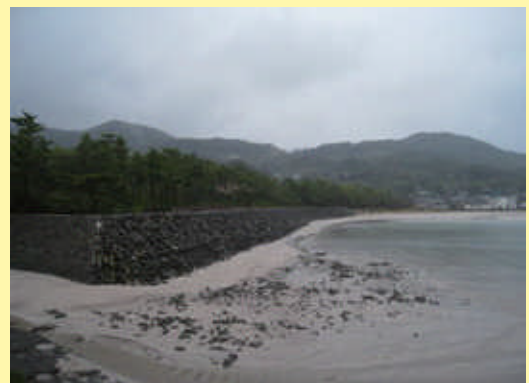
公共デザイン推進制度活用事例 (平戸市根獅子地区における防潮護岸工)
