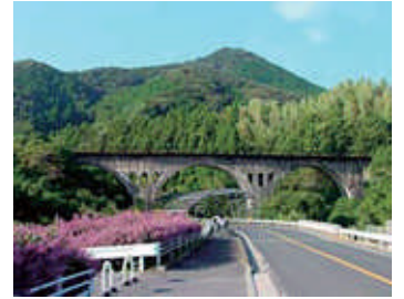
松浦鉄道福井川橋梁
