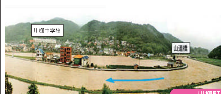
平成2年水害（H2.7.2）の被災状況
