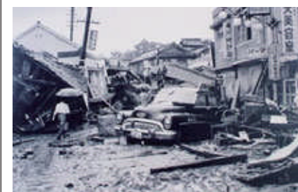
諫早大水害（S32.7.25）の被災状況
