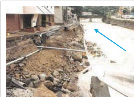
長崎大水害（S57.7.23）の被災状況
