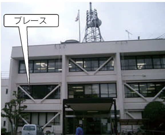
★ブレースを設置し、建物の強度を高め耐震性の向上を図る。
