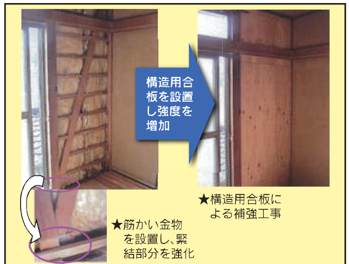
★ブレースを設置し、建物の強度を高め耐震性の向上を図る。
