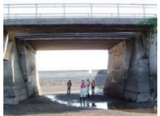
橋梁の定期点検状況
