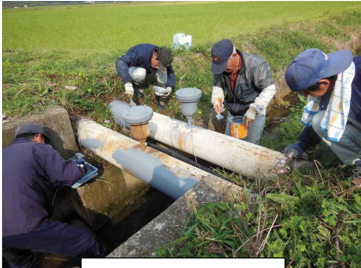
農業用パイプラインの塗装
