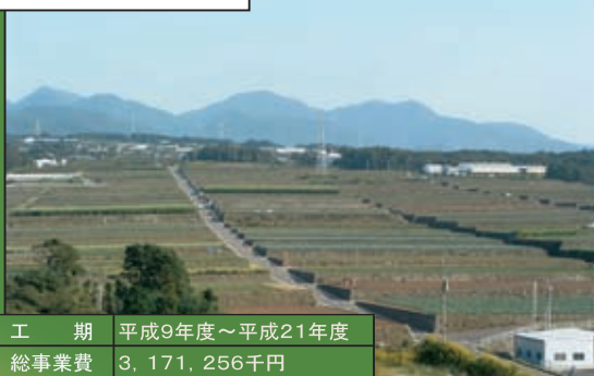
【畑地整備後の状況】
