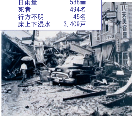
八天町の被災状
