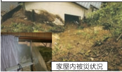
がけ崩れ被災状況 平成25年7月6日発生 佐世保市鹿子前町 鹿子前地区
