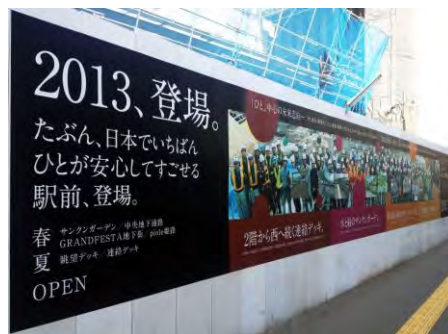
▲ 工事仮囲いの工夫例(姫路駅)
