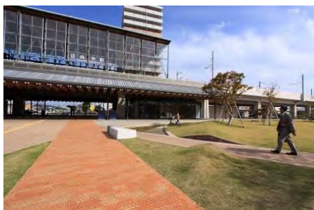
▲軸線が強調された舗装の例(日向市駅)
