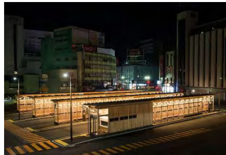
▲バスシェルターの例（秋田駅） 秋田駅西口のバスターミナルは、地場産木材で造られており、利用者にとって待合という機能面ばかりでなく、心地良い空間を提供しています。
