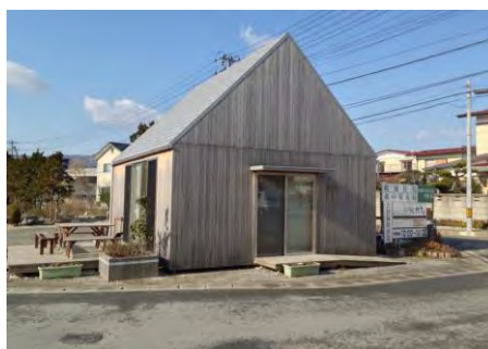
▲ 仮設建築物の例(陸前高田市・りくカフェ)
