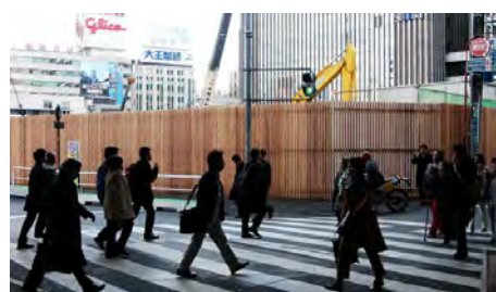
▲ 工事仮囲いの工夫例(東京都)
