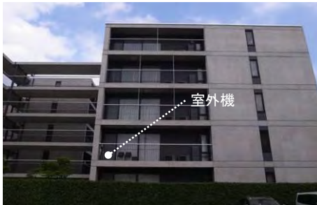
▲ 建築設備を目立たなくした集合住宅の例（東京都）
