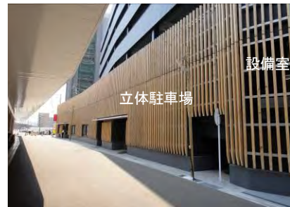
▲ 立体駐車場を目立たなくした例（大分駅） 立体駐車場の低層部に地場産杉材をルーバー状に取り付けることで、外から設備や車両などが目立たなくなるように工夫しています。
