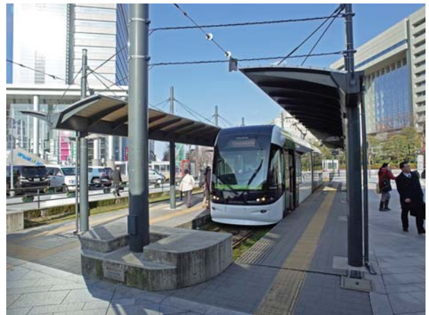
質感高くデザインされた電停シェルター [富山駅]
