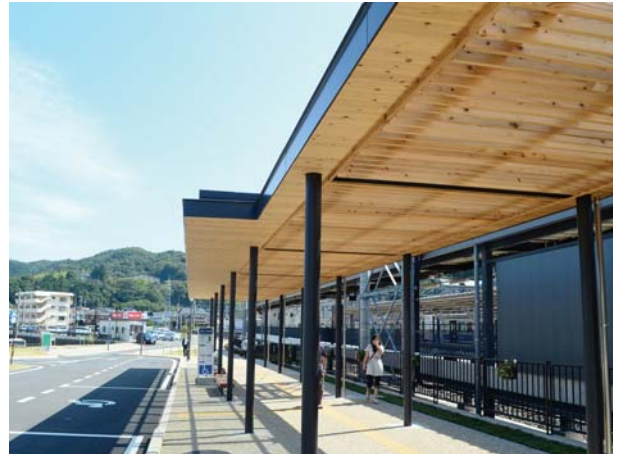
地場の木材を天井に用いた待合いシェルター [修善寺駅]
