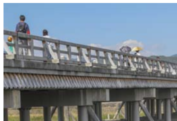
木橋の構造体を雨から防ぐと共に、意匠にもなっている。 [渡月橋の桁隠し/京都]
