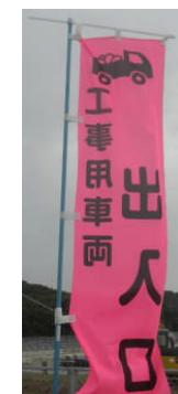
工事用車両出入口
