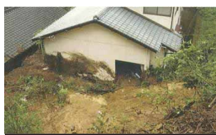
がけ崩れ被災状況 平成25年7月6日発生 佐世保市鹿子前町 鹿子前地区
