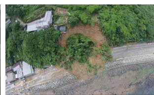
(一)国道251号 土砂災害状況 平成27年6月
