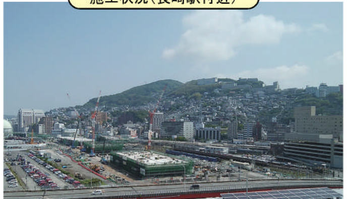
施工状況(長崎駅付近)
