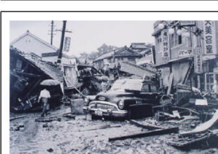
諫早大水害 (S32.7.25) の被災状況
