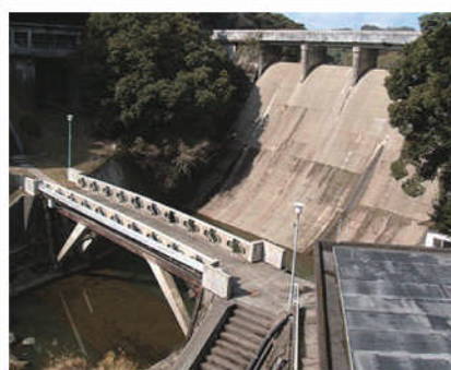
浦上ダム建設事業 (写真は既設浦上ダム)
