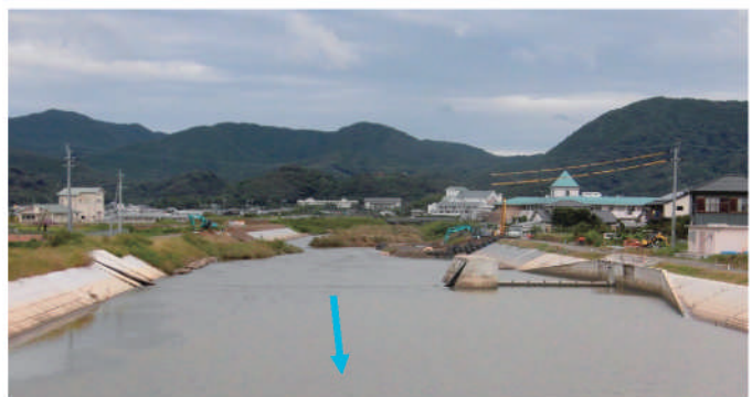
新開橋から上流側を撮影
