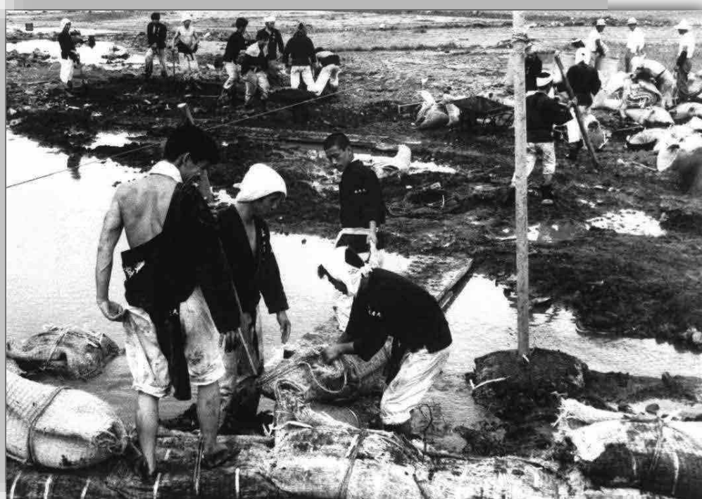
土のうによる水害からの復旧作業
