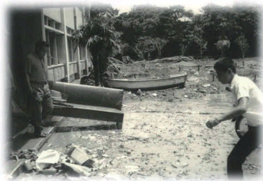
洪水あとの瓦礫（正面玄関）
