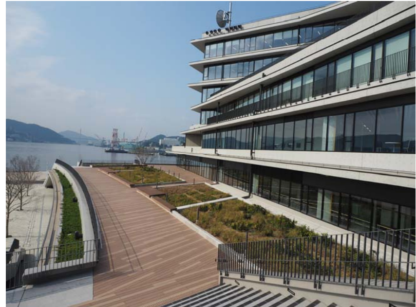
行政棟2階テラス全景
