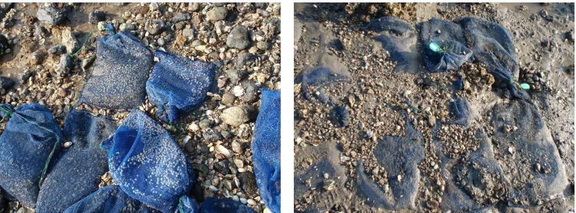
図4 ケアシエル袋設置状況 左：不安定（袋が移動し、ケアシエルなどが洗われている） 右：安定
