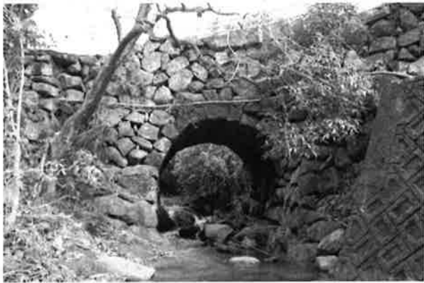
荒田下橋 明治26 (1893) 年
