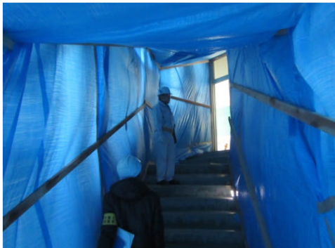
目張り(養生)を行い隙間をなくす
