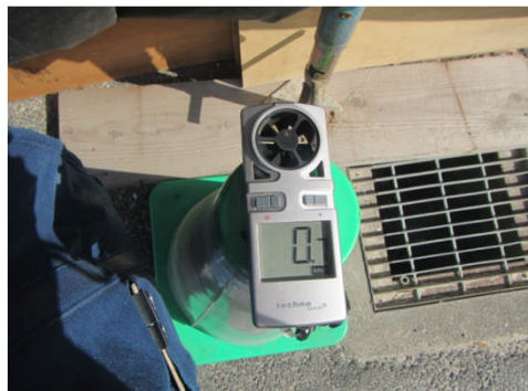
吹き付け作業の実施に風速計を使用
