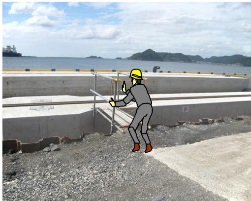
1) 高さ2.5mの路肩から1.5m離れた同じ高さ2.5mの構造物への移動の為に設置した渡り通路へ第三者立入防止措置をロープにて封鎖作業を行っていた
