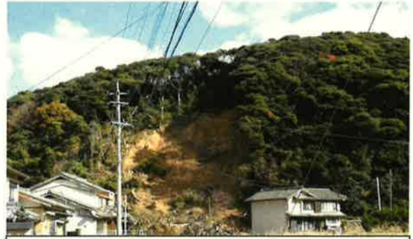
山腹崩壊被災状況 平成29年6月30日発生 苓岐市勝本町仲触薮田地区
