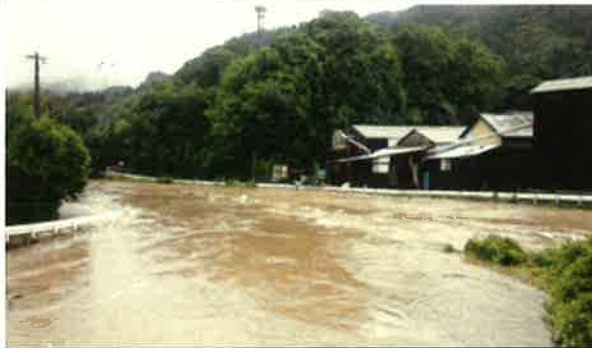
佐藤川 洪水による浸水状況 平成28年7月2日 対馬市
