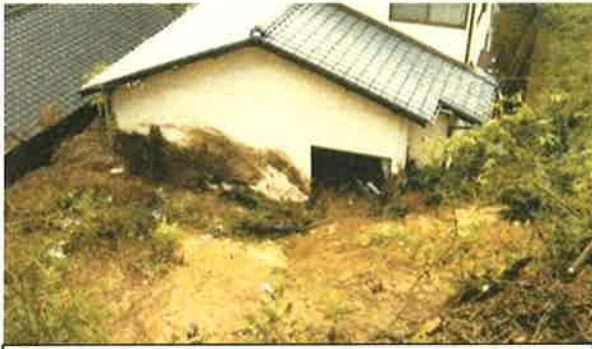
がけ崩れ被災状況 平成25年7月6日発生 佐世保市鹿子前町 鹿子前地区
