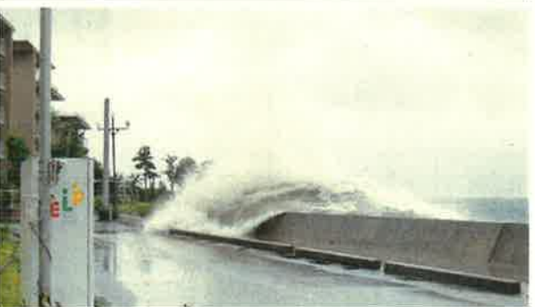
小浜港 高潮時の越波状況 平成24年9月 台風16号 雲仙市
