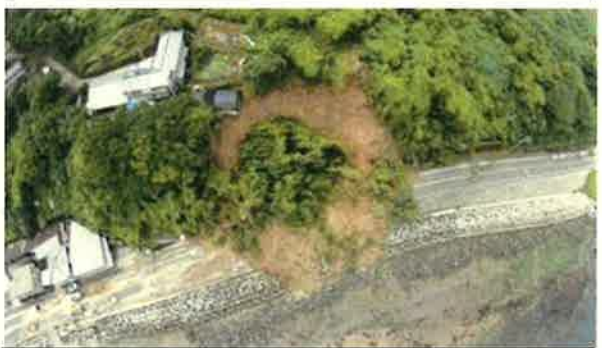
国道251号 土砂災害状況 平成27年6月
