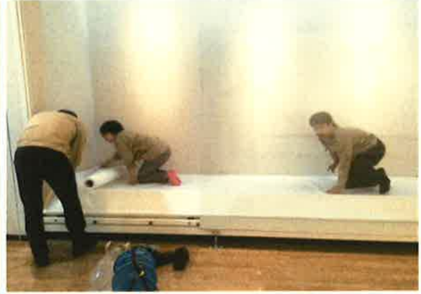
ガス吸着シート設置作業
