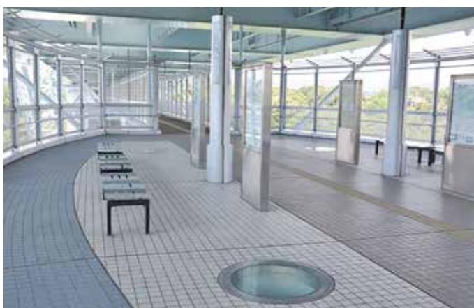
新西海橋（添架歩道） ※床面の窓から迫力ある「うず潮」を見学できます（利用は無料です）
