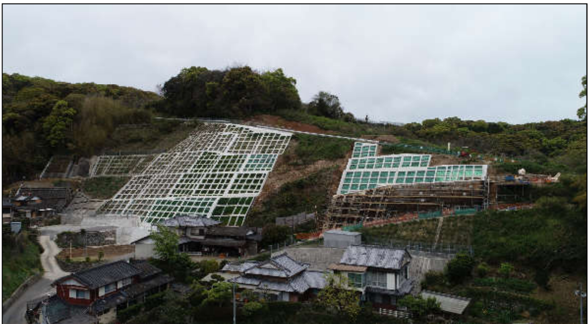
岩ノ口（２）地区急傾斜地崩壊対策事業
