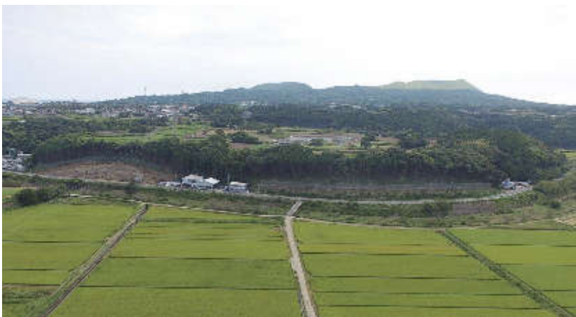
落石対策工事が進む 主要地方道福江富江線 大円寺地区
