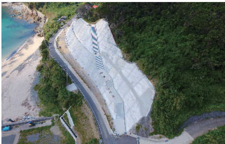
道路改良工事が進む 一般国道384号 黒瀬工区
