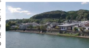
家屋が立ち並ぶ川棚川右岸
