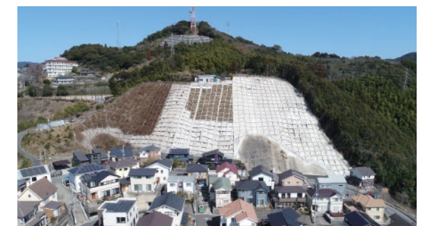
けやき台地区急傾斜地崩壊対策事業（長崎市）
