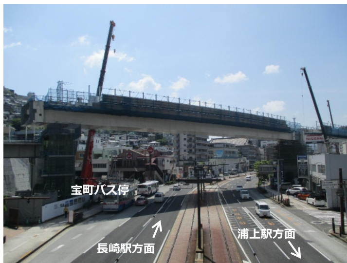
架設状況 (R2.5.19 撮影)
