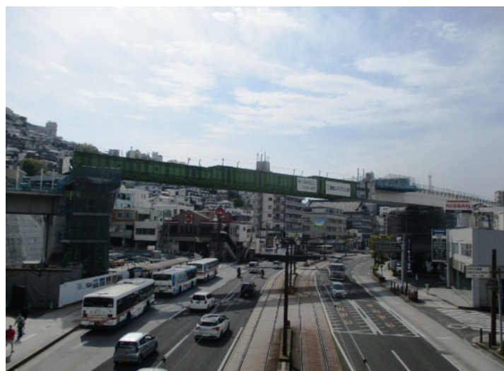
架設状況 (R2.4.15 撮影)
