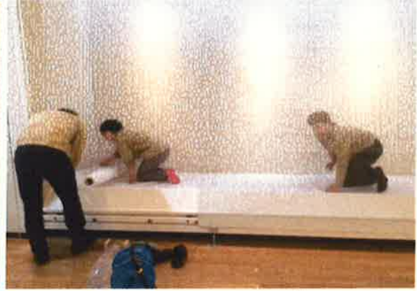
ガス吸着シート設置作業
