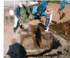
パイプライン補修
