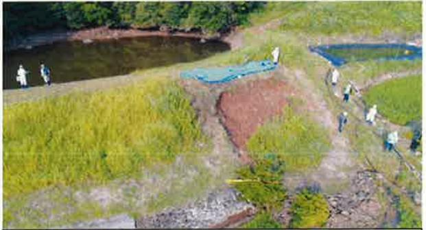
**ため池外堤法面の崩壊状況**
