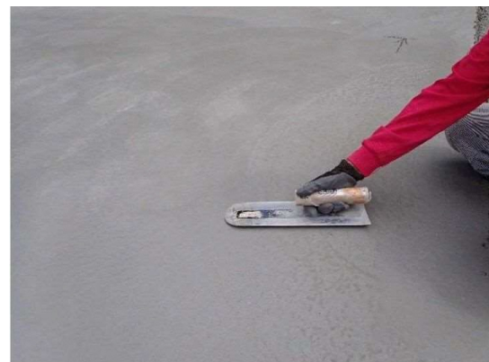
金コテの仕上げ状況
