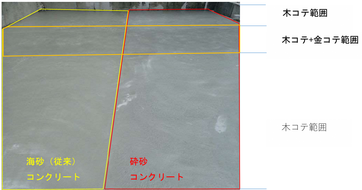
土間コン完成
