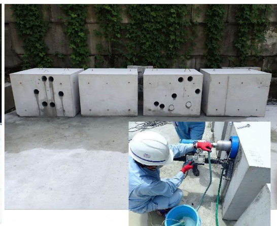
写真-5.5 充填状況確認コア採取
