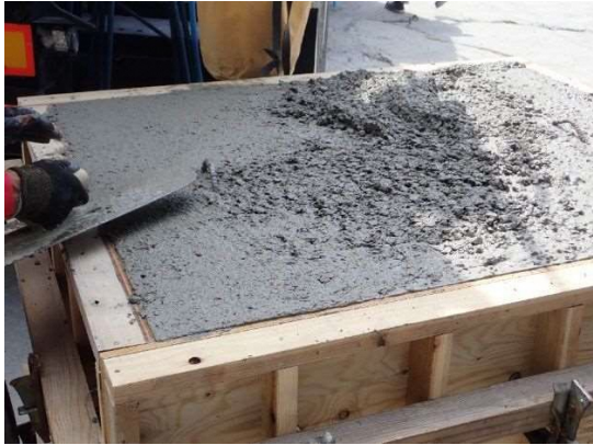
木コテの仕上げ状況
