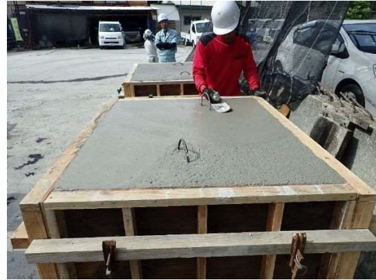
金コテの仕上げ状況
