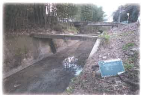
査定前着工により復旧した水路
