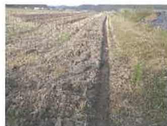
額縁明渠も併せて設置
